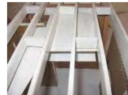
Vista Superior exterior
