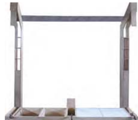
Montaje de piso aislante
