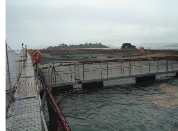
Plataformas flotantes que conforman un centro de engorda de salmones
