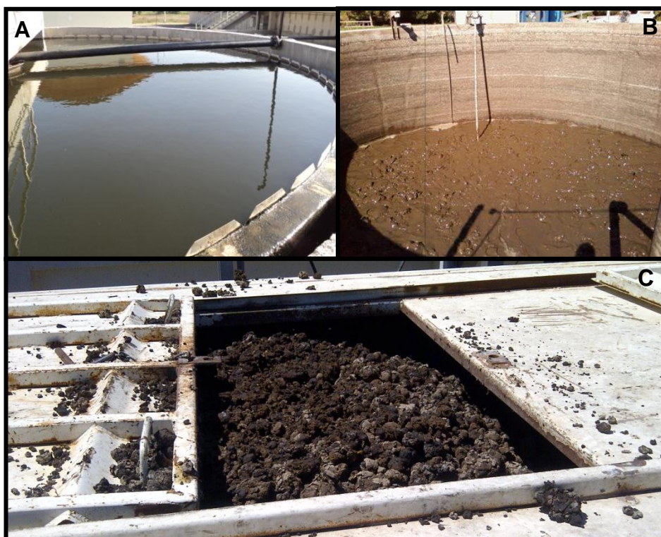
Figura 4.14 A) Espesador, B) Estanque acumulador y C) Lodos deshidratados y encalados en contenedor de lodos, PTAS El Monte.
