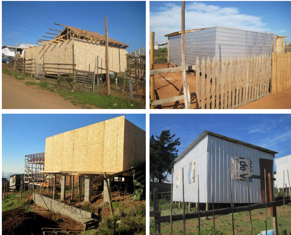
Imágenes. Casas de la Toma con su Primera Capa Construida
