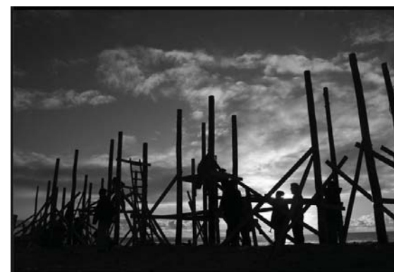
LUGAR Y FAENAS DE OBRA
