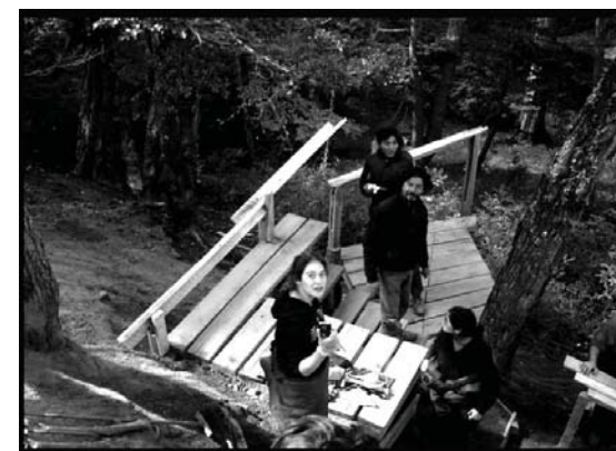
FAENAS DE OBRA/ PUERTO WILLIAMS * fotografía G. Sechi
