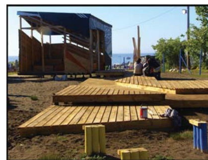
OBRA * fotografía M.Puentes
