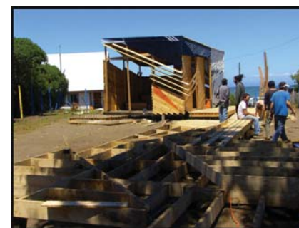
COLOCACIÓN DE COSTANERAS * fotografía M.Puentes
