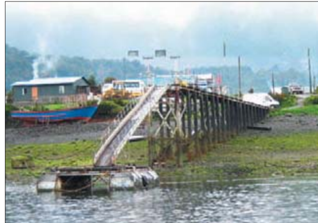
Muelle Hornopiren / Baja Mar Maniobra de Atraque en Muelle
