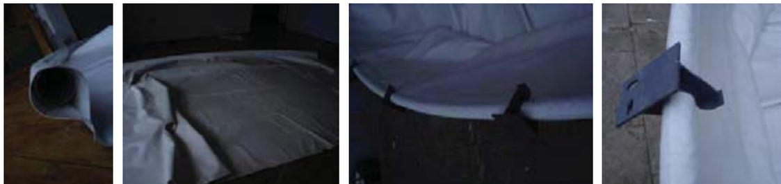
Cuando la tela ya está instalada en la parte trasera con el tubo de aluminio en la pared, se realiza el montaje de adelante: se tensan los cables de acero hacia las flanges con unos tensores y luego, se incorporan las prensas de madera en la tela y se tensan hacia la parte más alta de los pilares para generar la forma abovedada.
