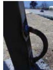
argolla que recibe el cable de acero que sostiene la presión del viento por sobre el fierro de extensión de la estructura-
