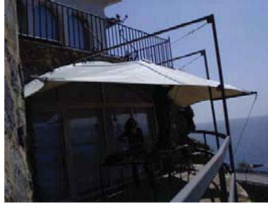
se realizó un post-tensado para generarle un abovedado a la carpa. Esto con la ayuda de unas piezas prensadoras que reciben todo el esfuerzo de la tensión.
