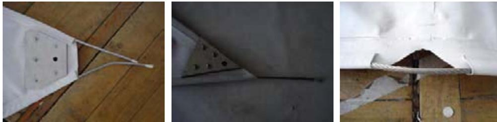
El tubo de aluminio se incorpora en el bolsillo de la tela, posteriormente se instalan las abrazaderas de fierro y al final se incorpora todo en el muro. Las abrazaderas se aseguran con estos hilos ya empotrados en la pared y se fijan con unas tuercas.
