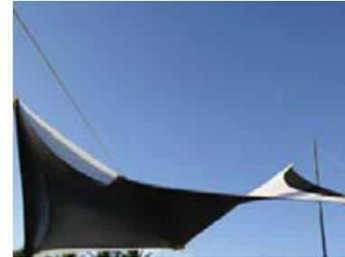
Este toldo de trabajo posee un área de 32 m<sup>2</sup> y se levanta 4 mt aproximadamente en su parte más baja. Los parantes tienen un alto de 7 mt aproximadamente y se empotran a 1 mt de profundidad. El paño se tensa hacia unas estacas, las cuales se encuentran ubicadas en dirección norte y sur para generar una sombra durante el día, siguiendo el recorrido del sol.
