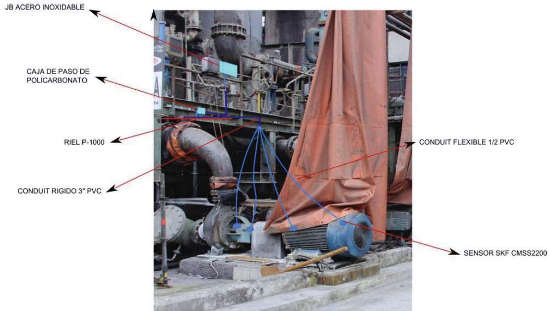
Figura 26: Esquema de instalación sistema monitoreo en línea Bombas P4
