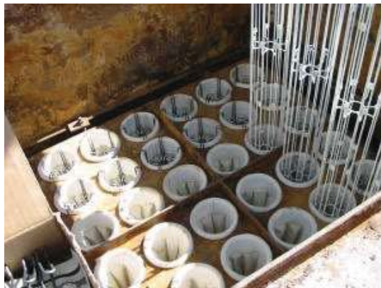
Figura 16. Instalación de filtro de mangas.
