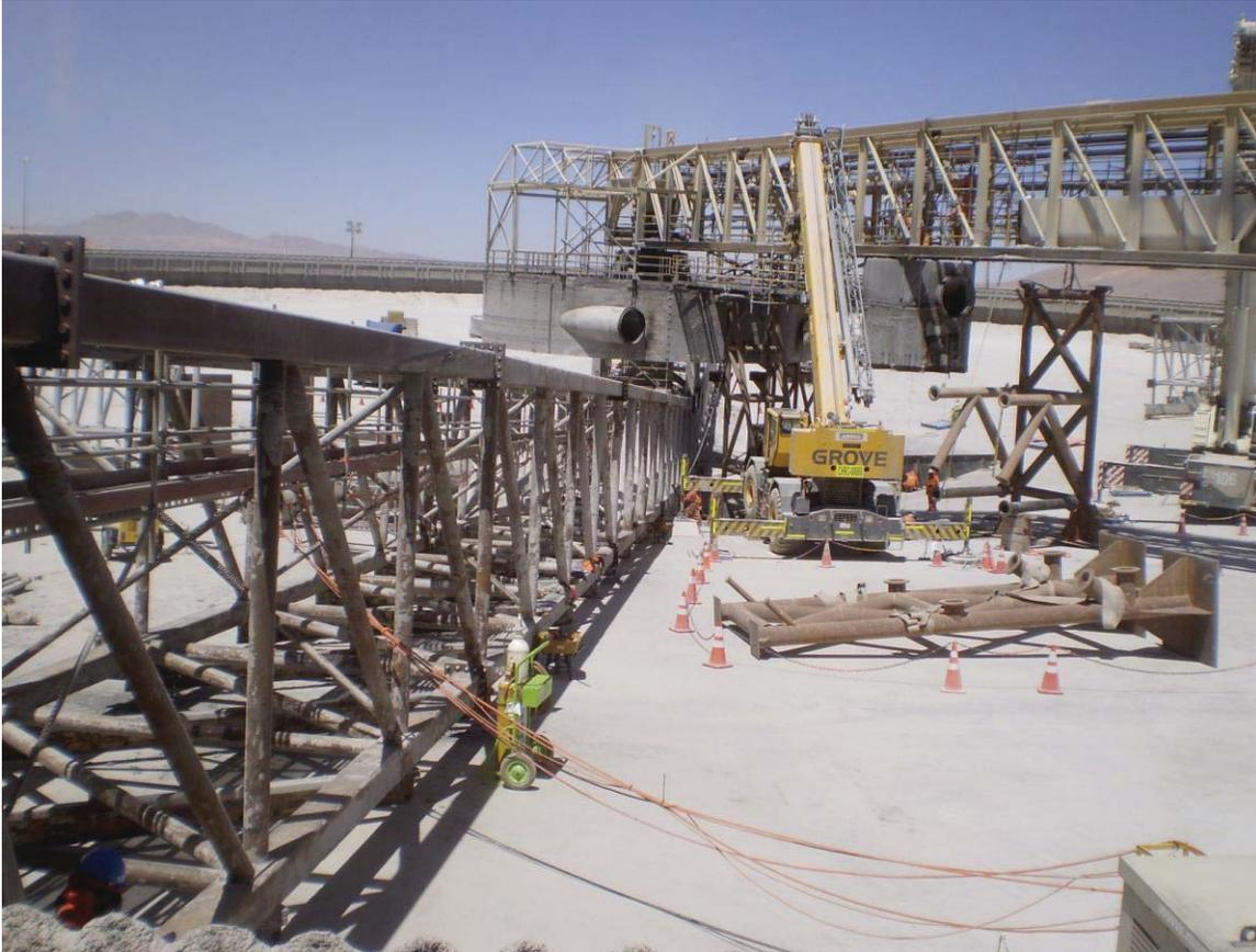
Fig N° 31: Rastra larga o motriz, en proceso de anclaje a piso.
