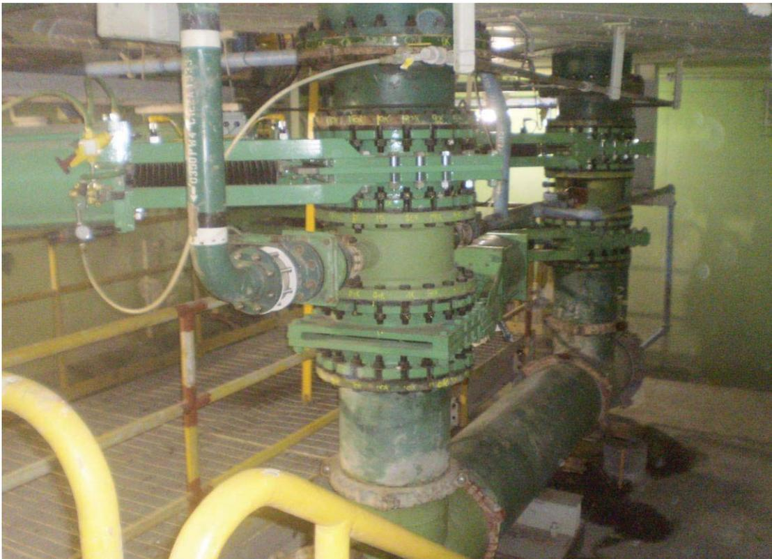
Fig. N° 48: Línea de descarga de relave en interior tunel de descarga.
