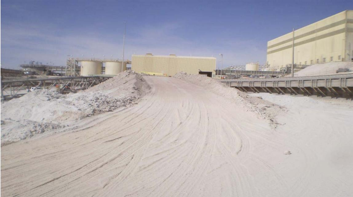
Fig. N° 25: Rampa de acceso de equipos a interior espesador
