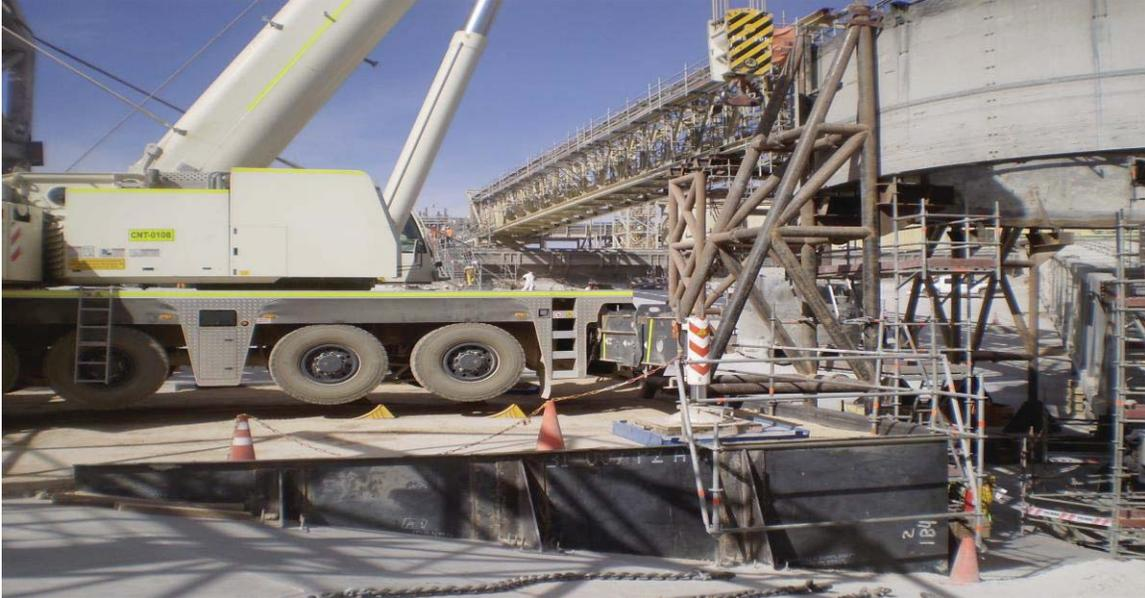
Fig N° 29: Muro de contención de relleno que soporta grúa Ac 350 Demag
