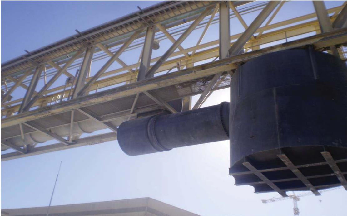
Fig. N° 45: Cajón y ducto traspaso hacia Cajón de presión.
