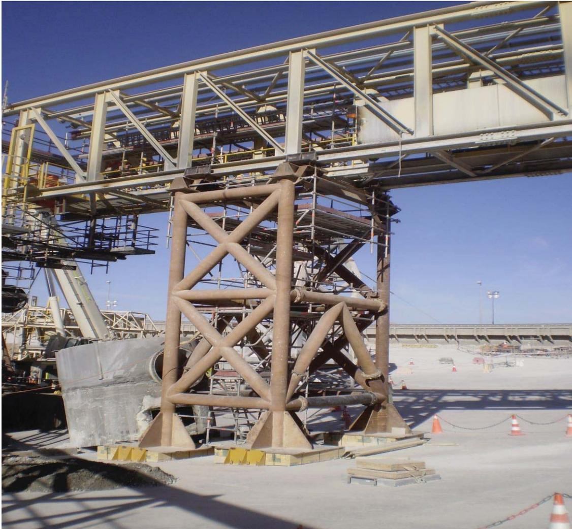
Fig N° 30: Soporte SP 1. Alzaprima soportante estructura de puente acceso que queda instalado después de retirar primer tramo que se apoya sobre columna.
