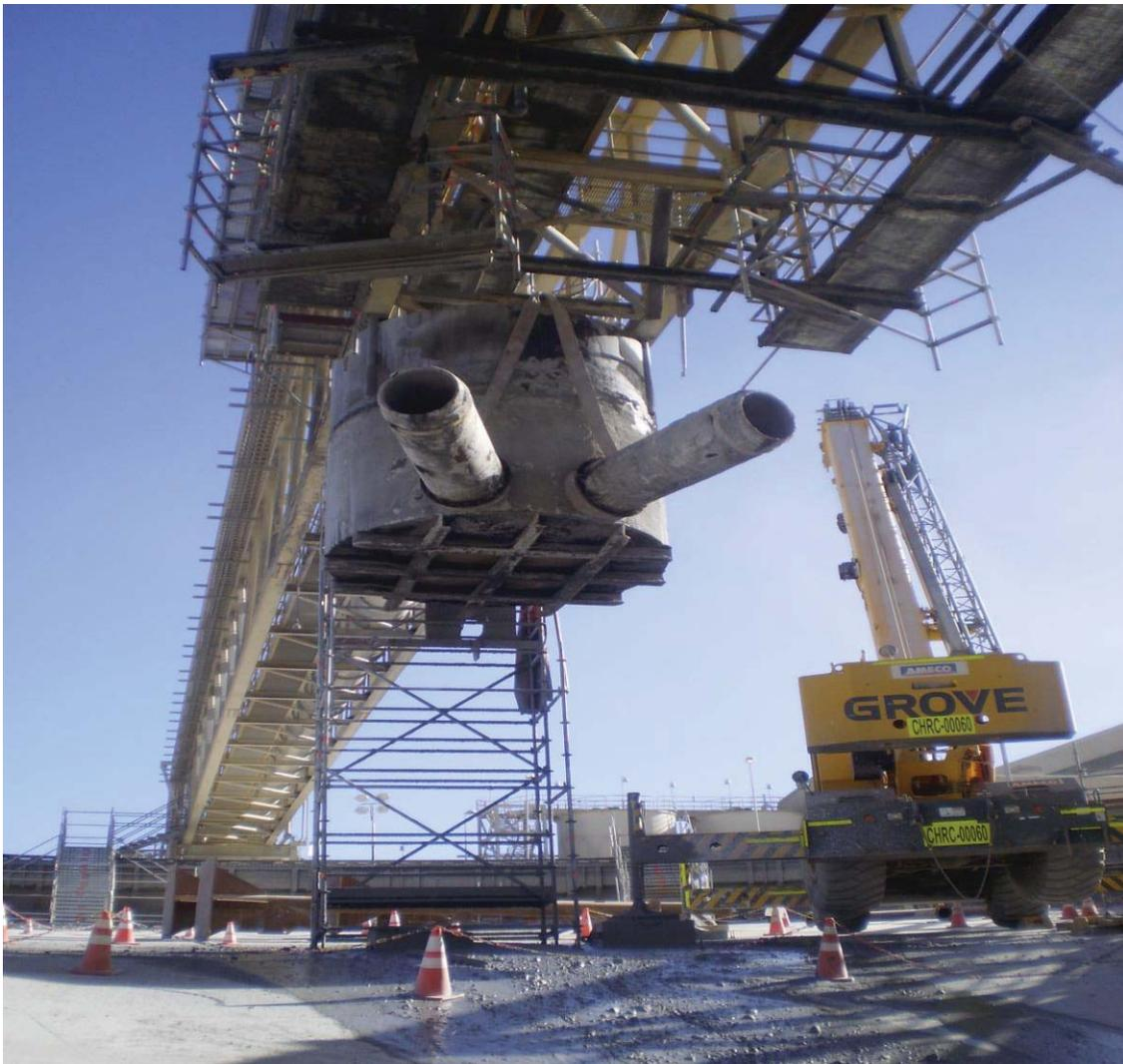
Fig. N° 28: Andamios colgantes, para realizar trabajos simultáneos y cajón de presión y toberas con desgaste que deben ser cambiados.
