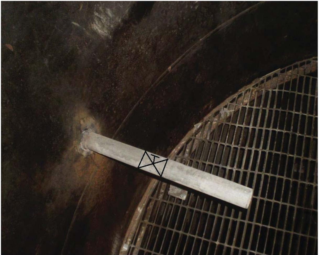
Fig. N° 61: Entrada de drenaje de aceite a interior columna. Se instalará una válvula de bola como se indica y un codo en extremo.
