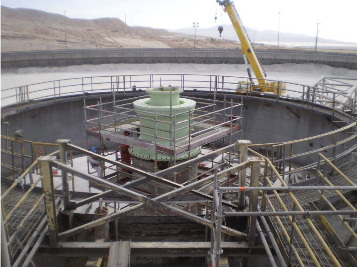
Fig. N° 37: Rodamiento central del espesador, sobre columna superior (Kings Post)
