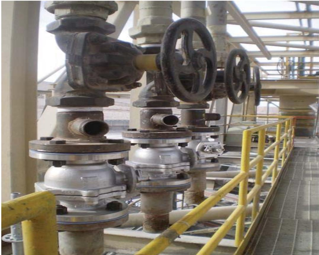
Fig. N° 62: Válvulas de adición de floculante.
