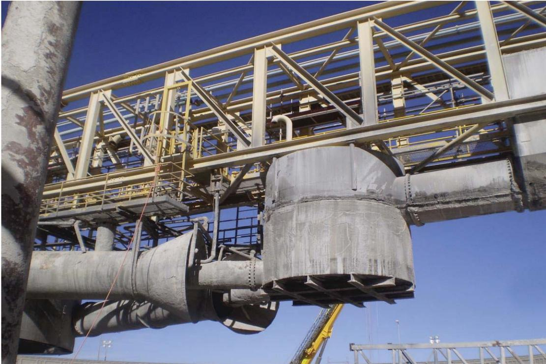
Fig. N° 44: Cajón de traspaso, Cajón de presión, Boquillas y Tubos E-Duc usados
