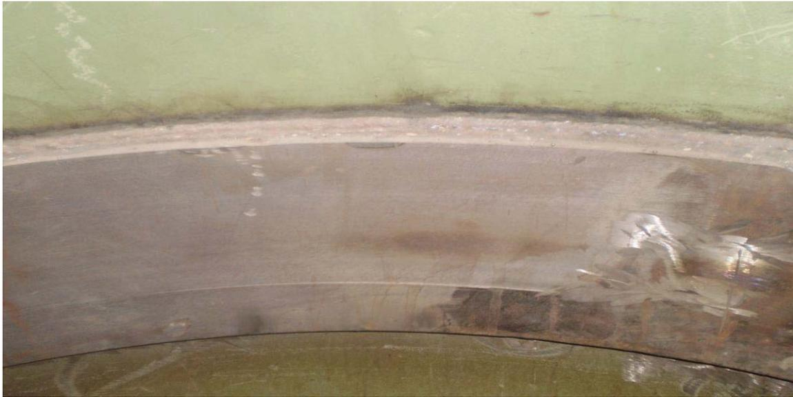
Fig. N° 57: Soldadura interior de punto N° 3 de Fig. N° 56
