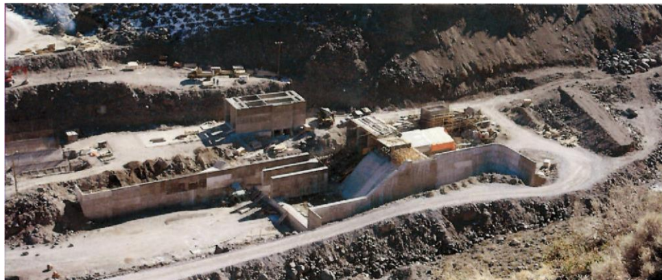
Figura 86: Captación Olivares, construcción barrera fijas y desarenadores
