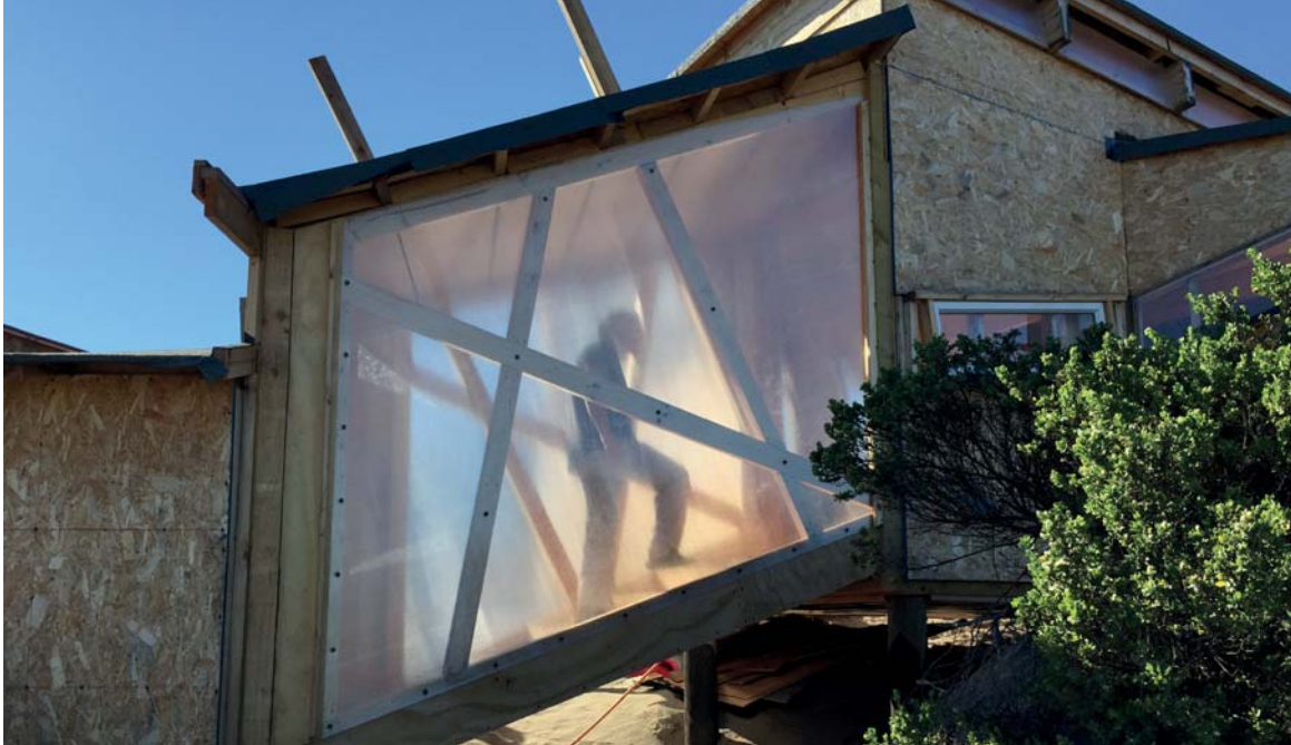
Fig. 12. Ampliación de la Cubícula de Locanda, propuesta que dialoga con la extensión mediante su permeabilidad, Ciudad Abierta. Fuente: Elaboración propia.
