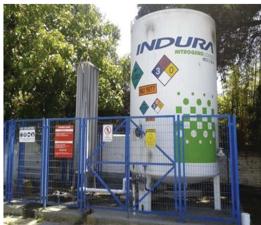
Ilustración 17: Almacenamiento de Nitrógeno líquido
