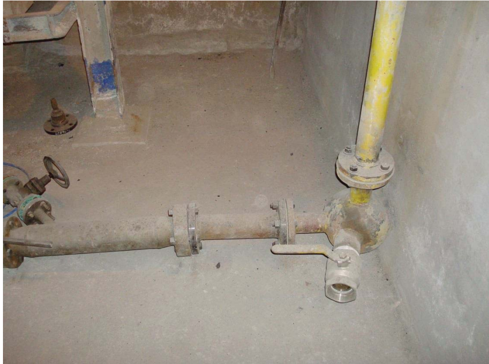
Figura 25: Estado de limpieza después de realizar la tarea.
