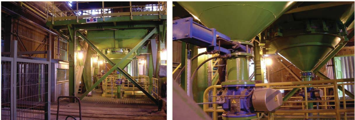
Figura 13: Vista general de los silos.
