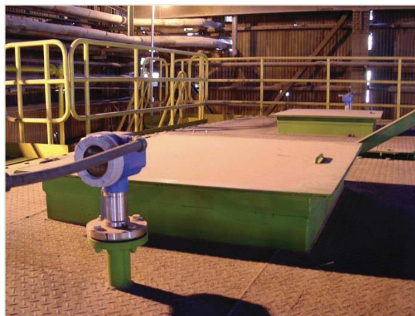
Figura 14: Vista superior de los silos.
