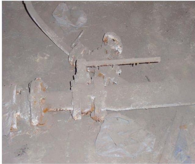
Figura 26: Comienzo de tarea Mantenimiento Mecánica.
