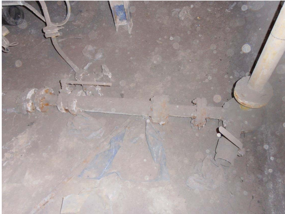
Figura 24: Estado de limpieza antes de realizar la tarea.
