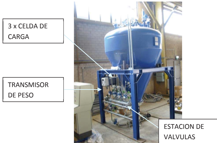
Figura 16: vista lateral del vaso de inyección.
