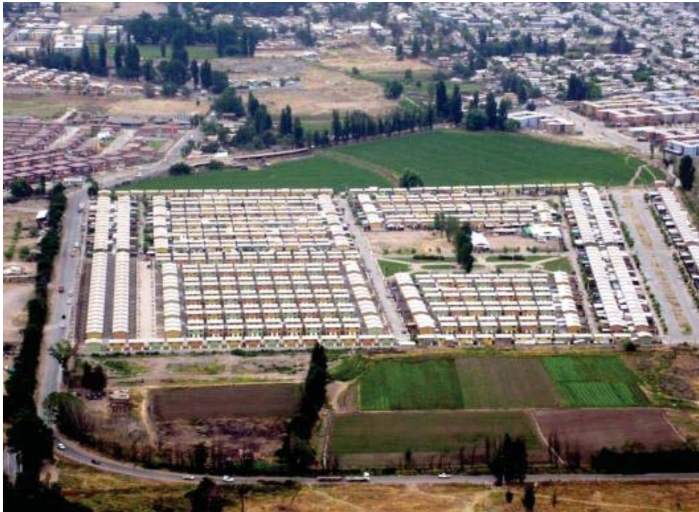
Proyecto de Vivienda Social en área rural, Santiago 104
