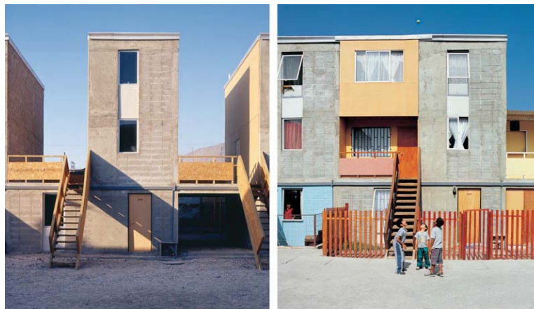
Quinta Monroy, Iquique, Proyecto Elemental, Una buena vivienda en un buen lugar 116
