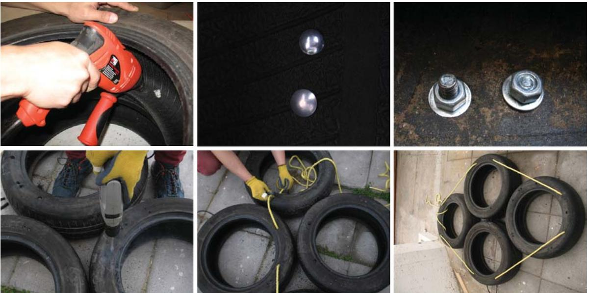
1. perforado de las caras de los neumáticos con broca normal para madera / 2,3 unión mediante pernos / 4. perforado con broca paleta de caras superiores / 5.se pasa la cuerda por los orificios / 6. resultado
