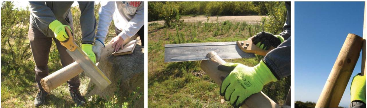
Luego de fijar las verticales en primer lugar, para tener un segmento de la estructura "fijo" y así lograr los ángulos y dimensiones deseados, se presentan las diagonales en los hoyos que les corresponden. Por el nivel del terreno cada rollizo tiene un largo particular, el que bordea los 2.3 metros desde el suelo hasta la unión, más el segmento que se funda. El corte se realiza mediante serrucho, envolviendo la circunferencia.
