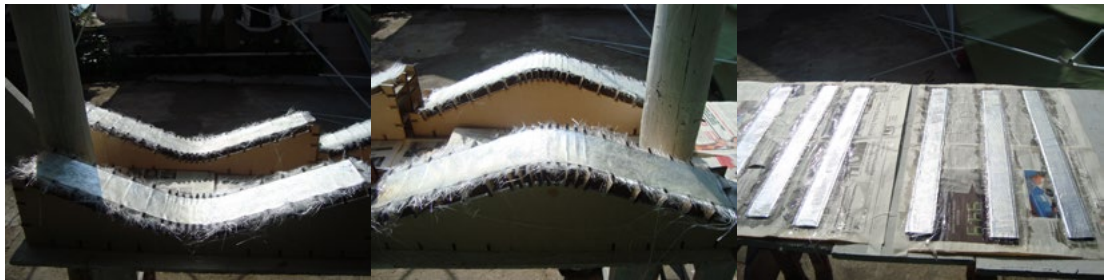
Figura 4.- a) y b) Moldes inferior y superior enfibrados con dos capas de matt. c) Struts verticales enfibrados en ambas caras con dos capas de fibra matt. Fuente: Propia.
