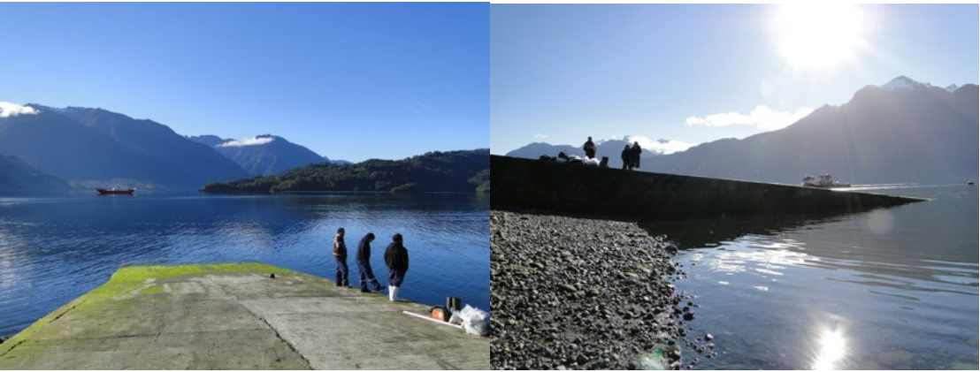
Figura 6.- Rampa de Hormigón para embarco /desembarco en Hornopirén. Fuente: Propia.
