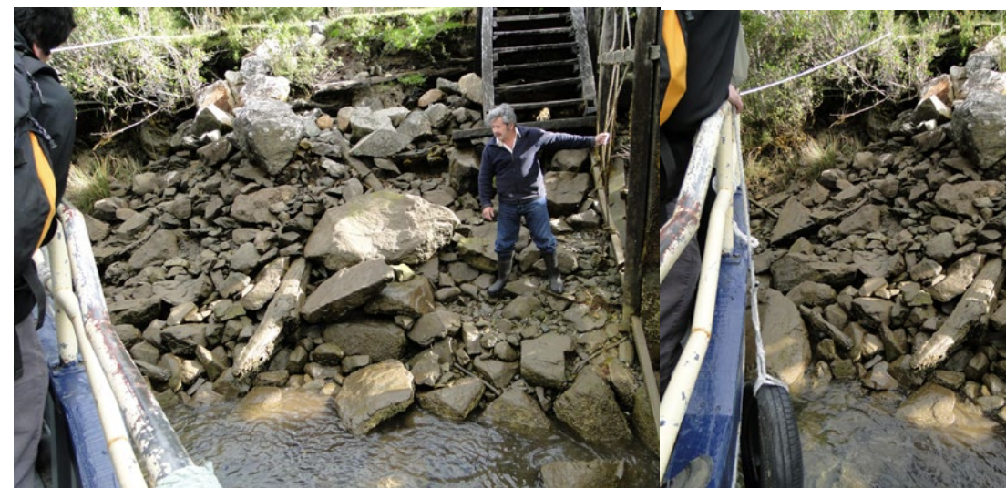
Figura 34 .- Condición del borde costero en Vodudahue. Fuente: Propia.
