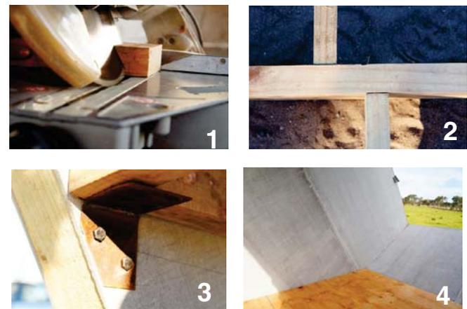
Fig 1: corte de las vigas en 30 ° para calce con pared del cubo
