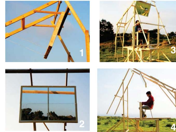
Fig 1:forma del vinculo superior, se deja un triángulo por debajo del espejo para poder estructurar una viga por dentro del cubo
