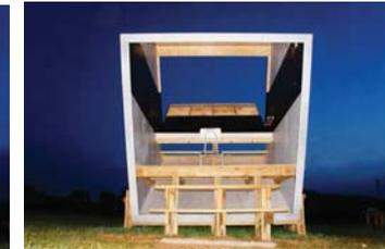
Fig 1: ubicacion de las pendientes de las celosías que de encuentran intercaladas entre cada una de las costillas de la ventana, esta angulación permite a su vez el desplazamiento de la lluvia por sus superficies y entable un entramado de luz
