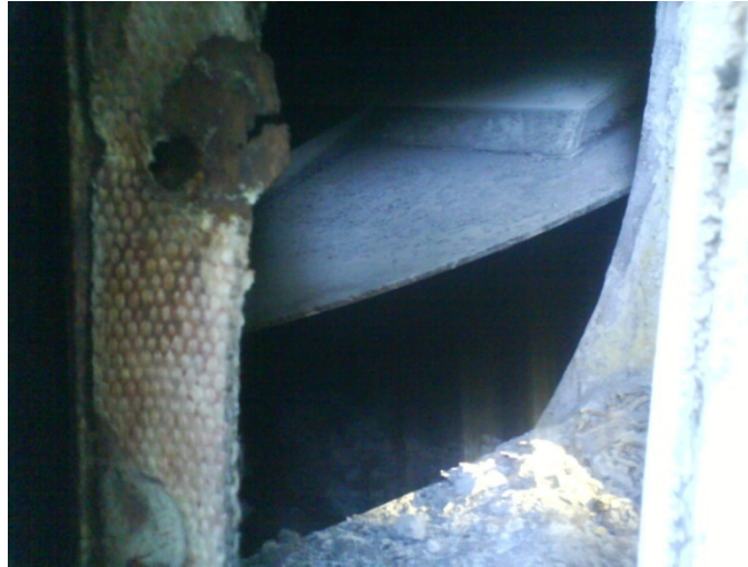
Fig. A.8.6 Movimiento Válvula Mariposa 56605
