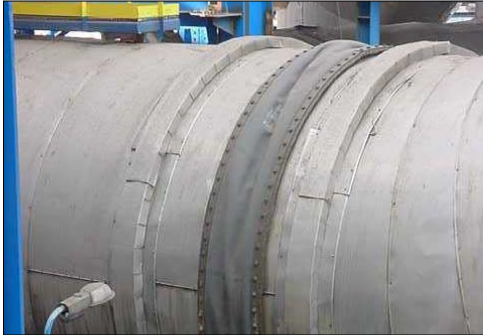
Fig 2.22 Vista Junta de Expansión Ducto a PLG's
