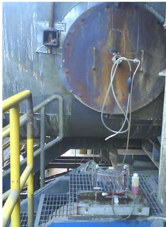
Fig.A.6.3 Toma Muestra Cámara Enfriamiento Radiativo en Paneles - Salida Cámara de Enfriamiento Radiativo: Se encuentra entre la cámara de enfriamiento y el ducto de alta velocidad, después de la válvula de guillotina.
