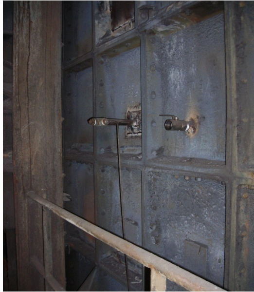
Fig.A.6.3 Toma Muestra Cámara Enfriamiento Radiativo en Paneles - Salida Cámara de Enfriamiento Radiativo: Se encuentra entre la cámara de enfriamiento y el ducto de alta velocidad, después de la válvula de guillotina.
