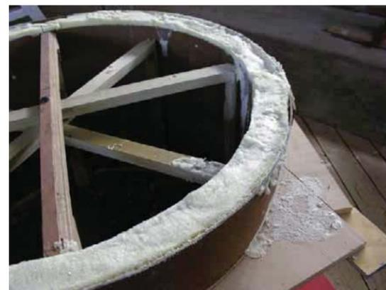
vaciado de poliuretano .construcción del anillo
