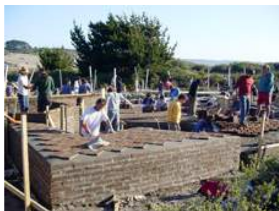
faena de limpieza final de la cubierta.
