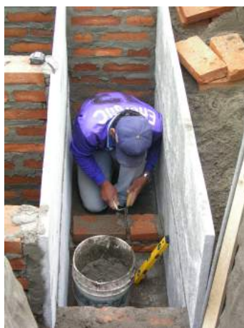
Construcción de la cámara decantadora.
