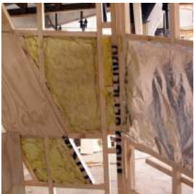
tabiquería del baño.
