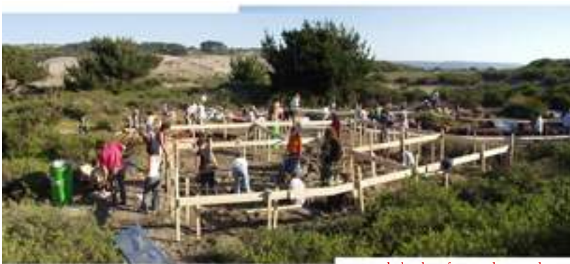
terreno de la obra, faenas de trazado, construcción de niveleta para esdificación de muros y fundacion.
