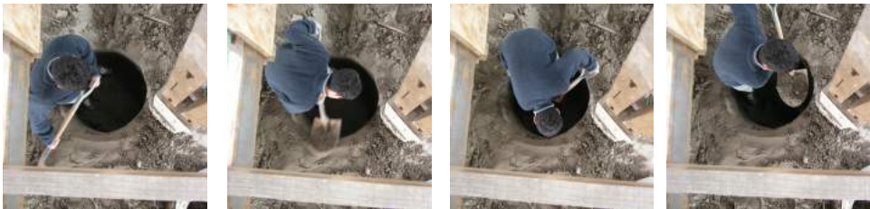
faenas de excavación de la duna para la instalación de las cámaras prefabricadas.
