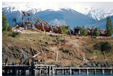
vista de la obra desde el otro lado del lago
