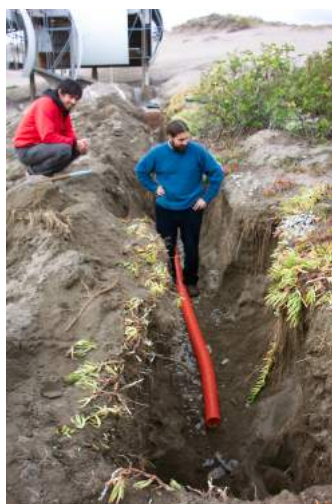
Tubo flexadren sobre una cama de huevillo.
