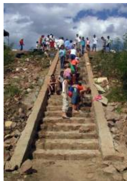
faenas de construcción.
