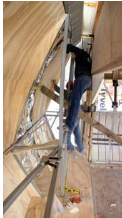
proceso instalación planchas de terciado.
