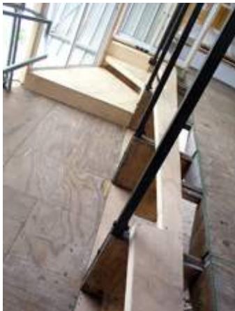
construcción de escalas en los extremos de los niveles de suelo
