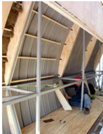
estructura de cuadernas y vigas para construir el muro interior.
