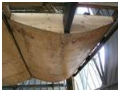
tapas de maderas que protegen la viga principal de los suelos colgantes.
