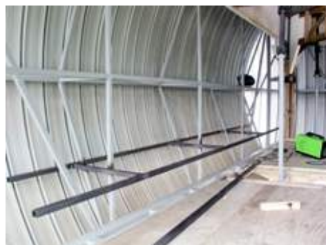
se soldó tarima a estructura fija
