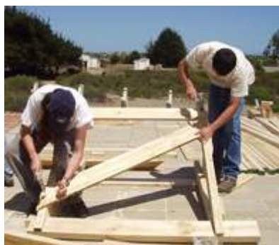
construcción de los caballetes para los apoyos del puente.
