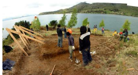
terreno de emplazamiento de la obra, limpieza, movimiento de tierra ubicación estructura de los fuselajes
