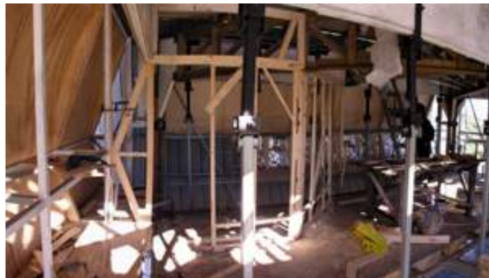
Vista tabique del baño.
