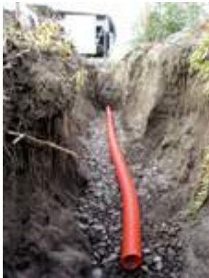
flexadren 100 mm, tubo con perforaciones en sus 360° para el drenaje de la descarga de agua que proviene sin sólidos desde la cámara decantadora.
