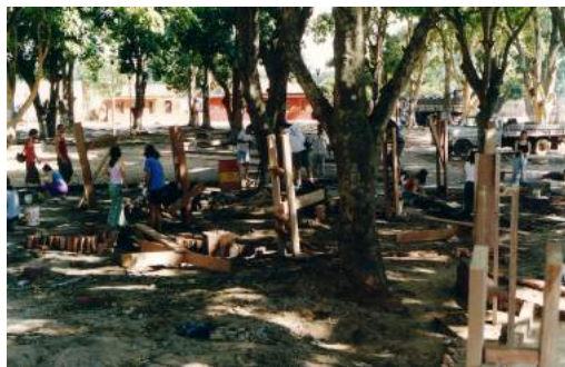
imágenes de la obra bajo la luz mangal.
