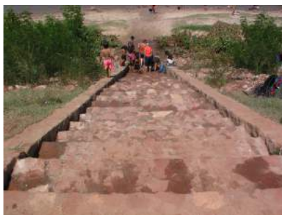
la escalera donde se instalaron las placas.
