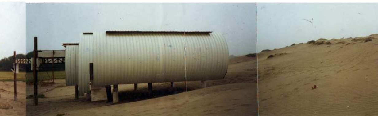
vista sur oriente
