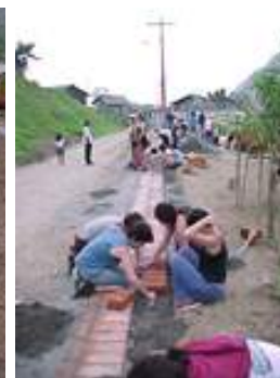
faenas de trazado y construcción de la calzada de ladrillo.
