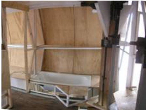
ducha aprovechando vacío de estructura fija
