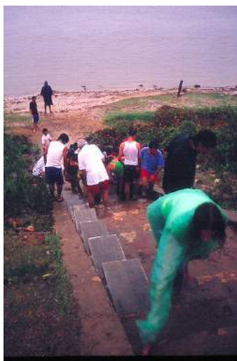
faenas de instalación de los peldaños.
