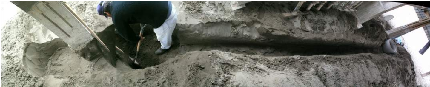
vista desde la cámara del pilar de acceso hasta el pilar donde se ubican las dos cámaras de descargas del baño.
