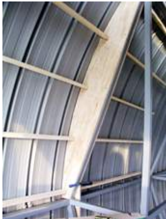
estructura de cuadernas y vigas para construir el muro interior.
