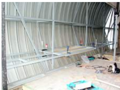
se consolidó con terciado moldaje 15 mm
