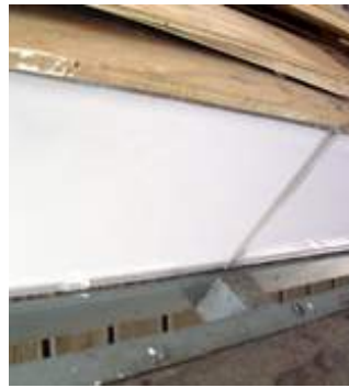
cepillo vinculo con suelo movil, se apoya permitiendo que el suelo se deslice
