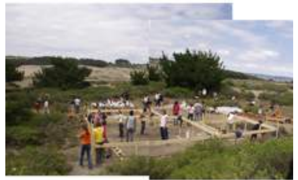
terreno de la obra, faenas de trazado, construcción de niveleta para esdificación de muros y fundacion.
