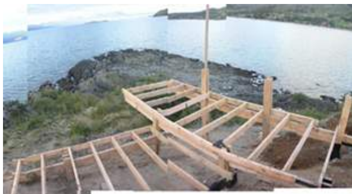
estructura de vigetas de los dos suelos del muelle
