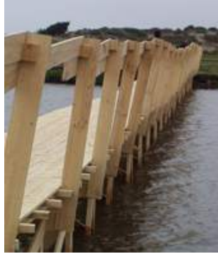
barandas puente terminado.
