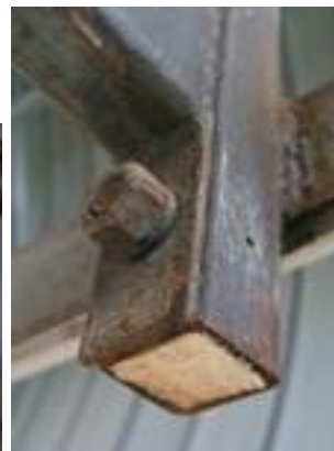
Tapones de madera para que no se oxide al interior.
