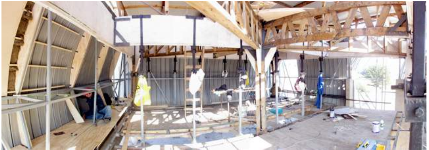
primeras faenas, tarina ya terminada, instalación de cuadernas para construir muros interiores.
