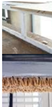
cepillo vinculo con suelo movil, se apoya permitiendo que el suelo se deslice
