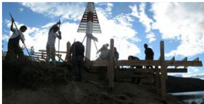
faenas construcción muelle, construcción suelos adyacentes
