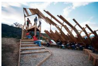
acceso a torre que rematan los fuselajes
