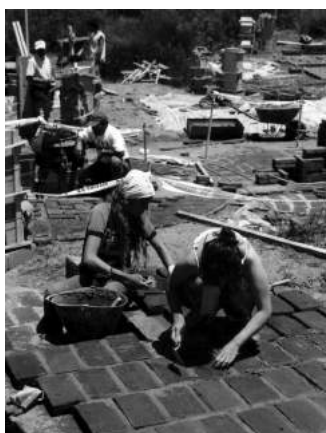
colocación de ladrillos en el suelo
