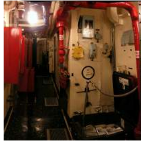
vista pasillos,sist. seguridad.
