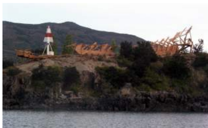
vista de la obra desde el lago
