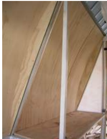
plancha de terciado 9mm curvada
