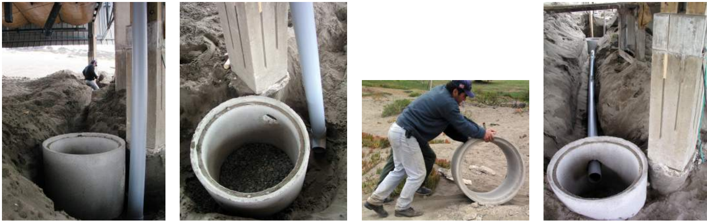
ubicación de las cámaras junto al pilar.
