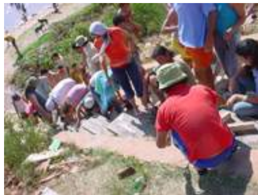
faena de instalación de peldaños en la obra.
