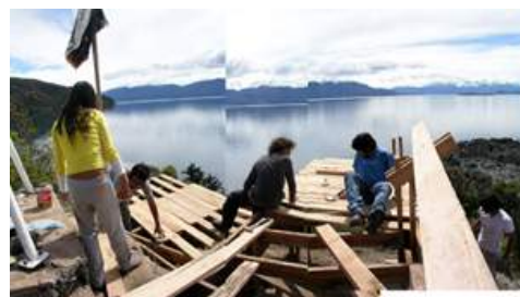
faena de entablado y construcción de la baranda
