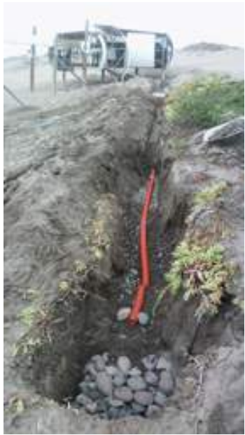
se cubrió tubo del dren
