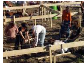
terreno de la obra, faenas de trazado, construcción de niveleta para esdificación de muros y fundacion.
