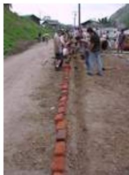
faenas de trazado y construcción de la calzada de ladrillo.
