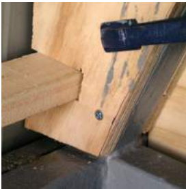
detalle cuadernas con viga tabique.
