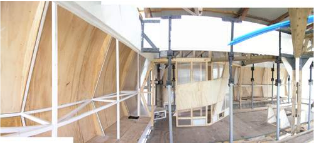
obra terminada, vista de los muros interiores y el lugar de ubicación del baño
