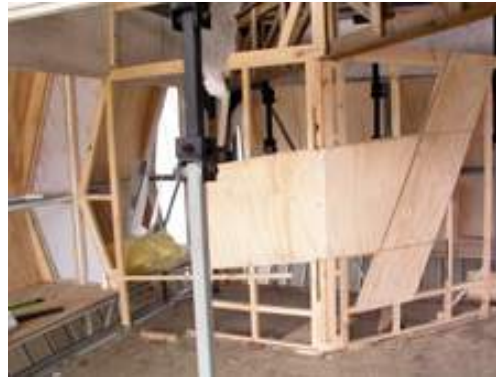
paños solidos de terciado, solo tapan altura más pudorosa del cuerpo al interior del baño, el resto semitransparente
