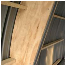
vista estructura de cuadernas.
