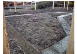
terreno de la obra, faenas de trazado, construcción de niveleta para esdificación de muros y fundacion.
