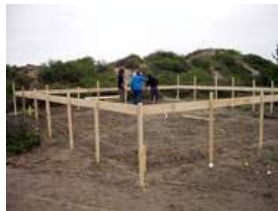
terreno de la obra, faenas de trazado, construcción de niveleta para esdificación de muros y fundacion.
