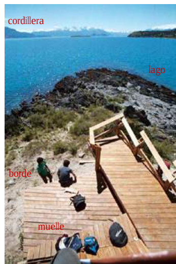
relación de remate de la obra al aproximarse al lago
