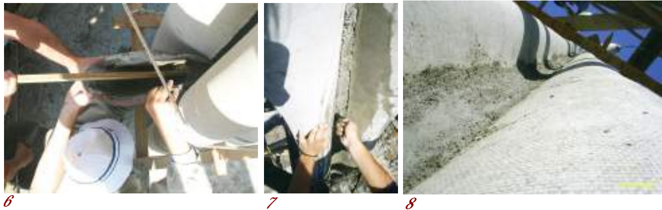
6. Llenado del centro de la columna. / 7. Afinamiento de l exterior concretado. / 8. Afinamiento terminado.
