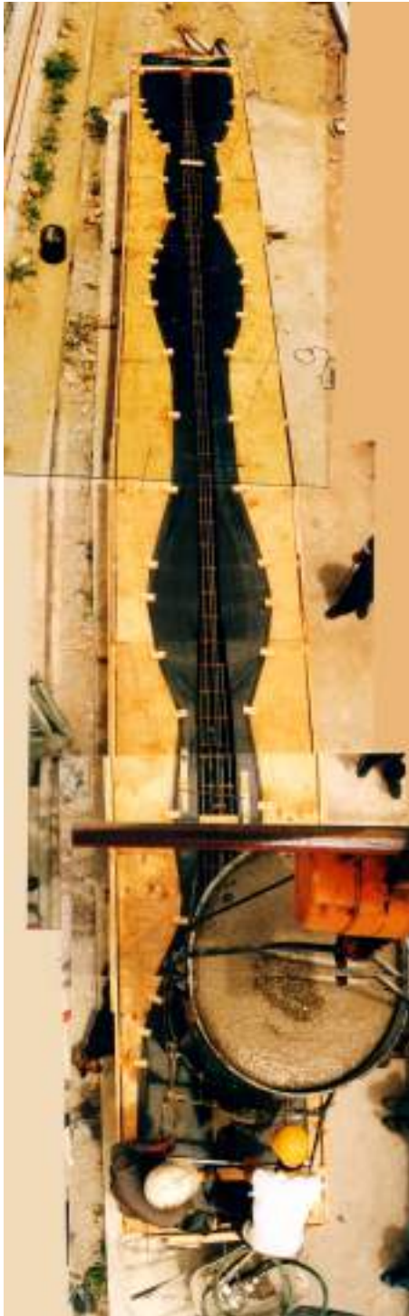
1. Proceso de vaciado de hormigon, vista desde la grua portico.Se puede observar el capacho con el concreto en su interior desde arriba / 2.Boquilla del capacho. / 3.Vibrador.La faena del hormigonado y vibrado se realizan juntas.
