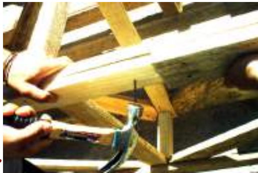
5. Presentacion del alargue junto a la estructura antigua, se puede observar la diferencia de color entre ambas. / 6. Union del alargue al moldaje antiguo. / 7. Corte de la superficie del meson. / 8. Meson entero, cubierto con polietileno para disminuir los efectos del sol y la lluvia.
