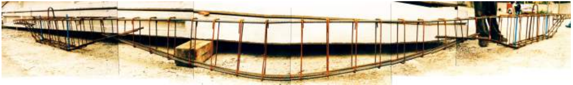
.Panoramica de la enfierradura, se pueden observar los dos estribos largos.
