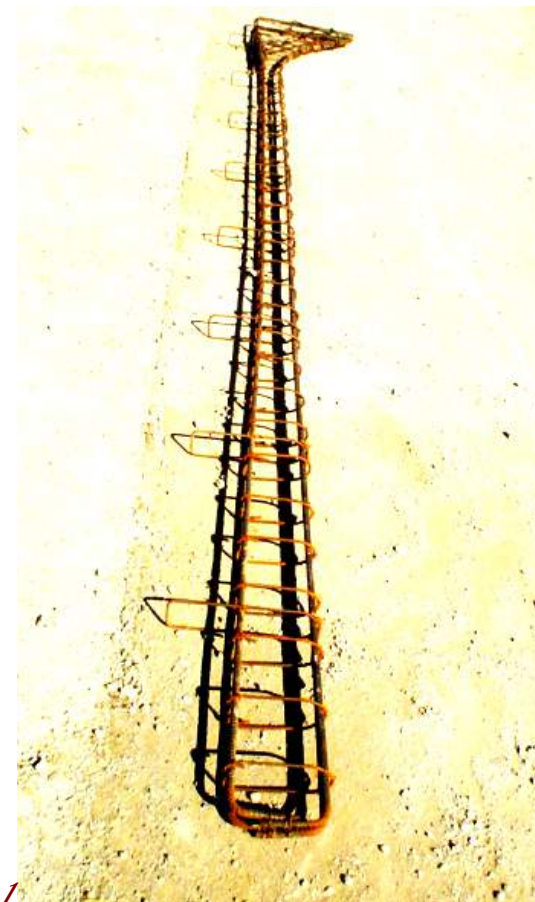
1. Enfierradura del pilar:
