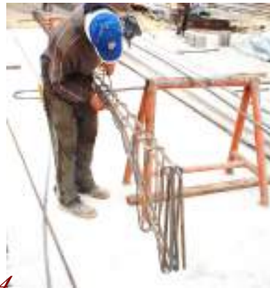
2.Enfieradura, vista interior / 3.Enfieradura de la cabeza del pilar / 4.La pieza es fabricada por los enferradores de INDHERCO. / 5.Estribos, notese el estribo de la izquierda, es mas largo porque luego servira para el montaje de la columna.
