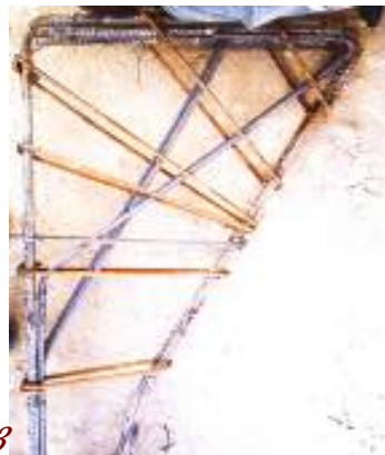
2.Enfieradura, vista interior / 3.Enfieradura de la cabeza del pilar / 4.La pieza es fabricada por los enferradores de INDHERCO. / 5.Estribos, notese el estribo de la izquierda, es mas largo porque luego servira para el montaje de la columna.
