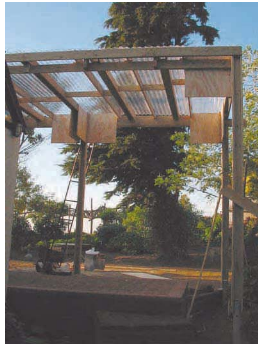
vista general de la cubierta casi terminada.
