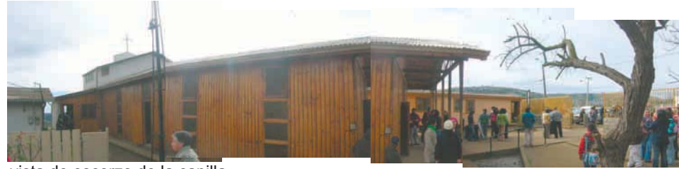
vista de escorzo de la capilla.
