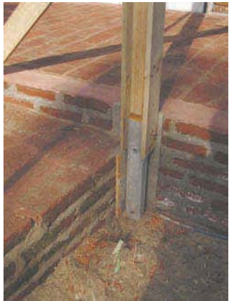
detalle de una base de los pilares.
