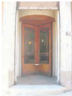
esquina vértice del pórtico.
