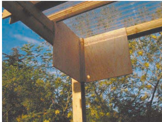
detalle de una bisagra rígida
