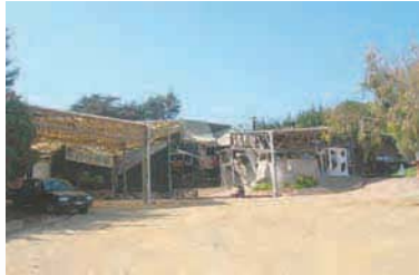
desde el patio, vista hacia las dos hospederías.
